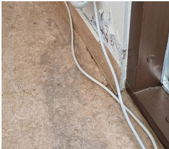
MYND 7 Leki með gluggum og inngangshurðum í sólskála, hækkaður raki undir dúk.
