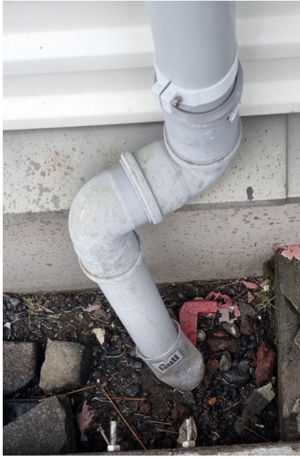
MYND 5 Niðurfallsrör frá þakrennum liggur ekki í regnvatnslagnir.
