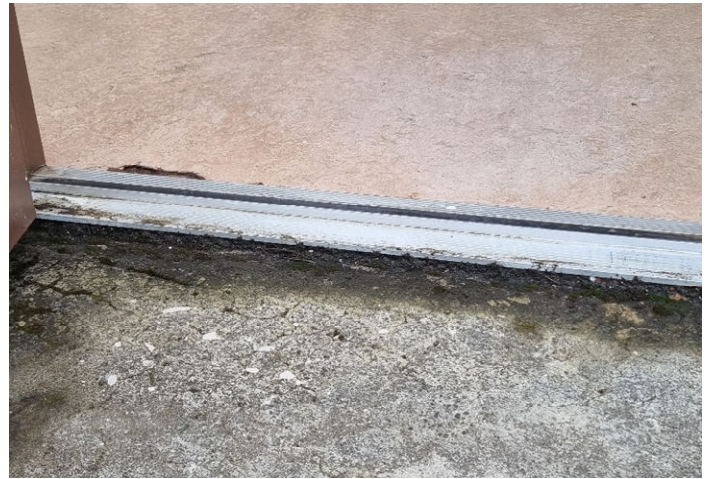
MYND 8 Leki með gluggum og inngangshurðum í sólskála, hækkaður raki undir dúk.
