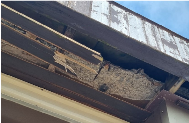
MYND 1 Skemmdir í steiptum þak kanti og þak kantur illa farinn vegna raka og fúa.
