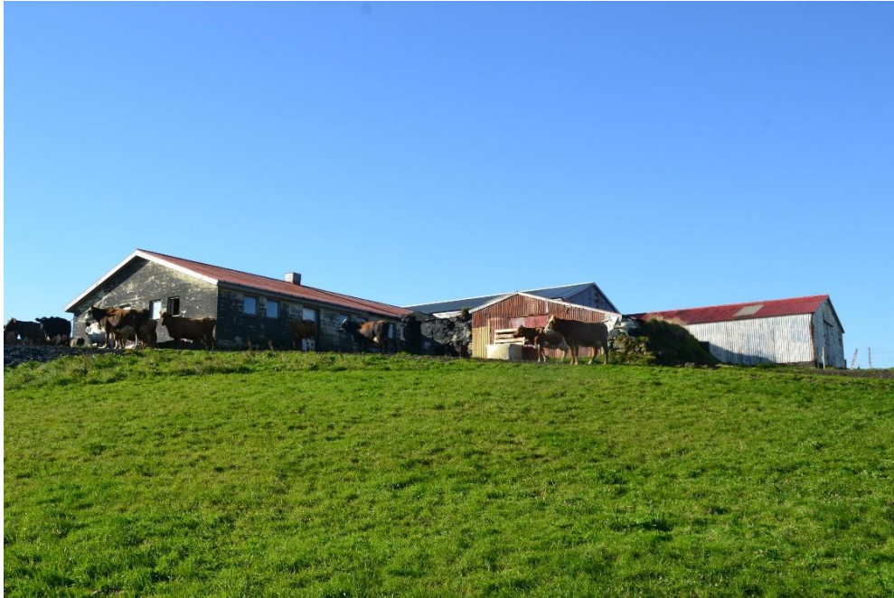
Útihús á Herjólfsstöðum 2, byggð 1959-1983. Steypa, torf, timbur og járn.
