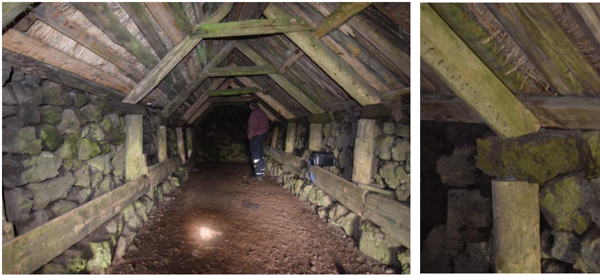
Sauðahús í Áftaveri, melur lagður á langbönd og rafta undir torf.
