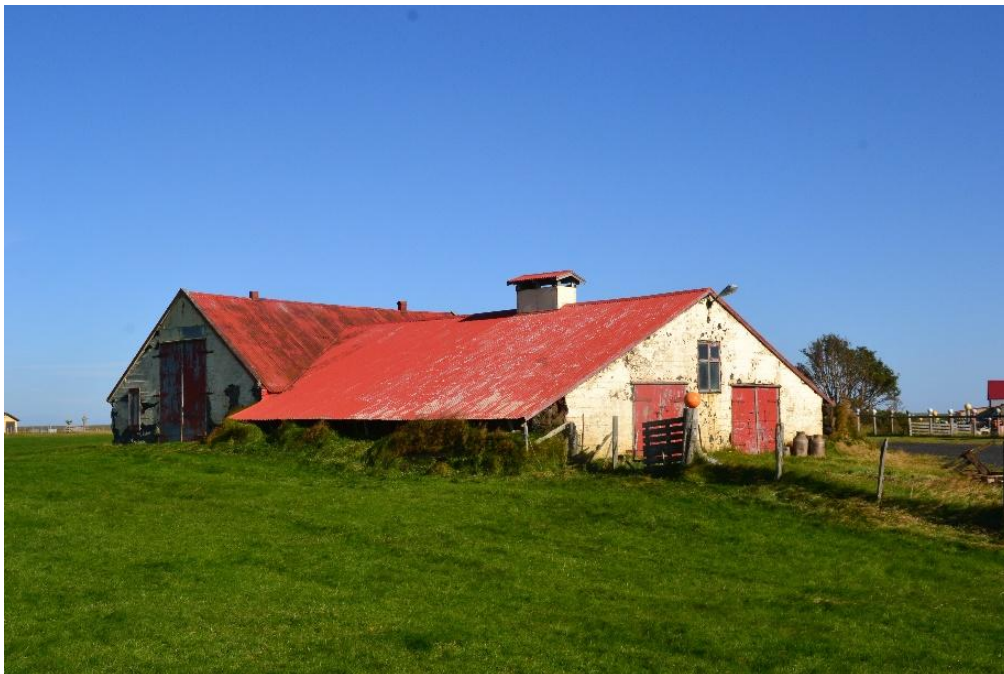
Gömlu fjárhúsin á Bykkvabæjarklaustri ll. Steypa, torf, timbur og járn
